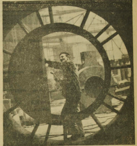
Montaż cichobieżnych wentylatorów w Fabryce Maszyn Górniczych w Zabru. CAF — fot. Jakubowski
