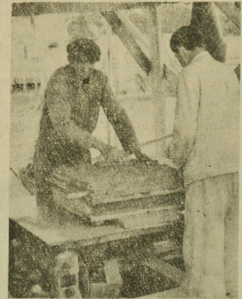
W specjalnej formie wyrabla się elementy ściienne.
