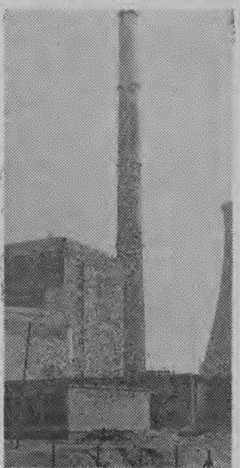
Budowana pod Będzinem elektrownia „Łagisza” będzie jedną z najekonomiczniejszych w kraju. Złożą się na to zarówno wielkość i nowoczesność oraz fakt, że przystosowana zostanie ona do spalania najtańszych gatunków węgla.
