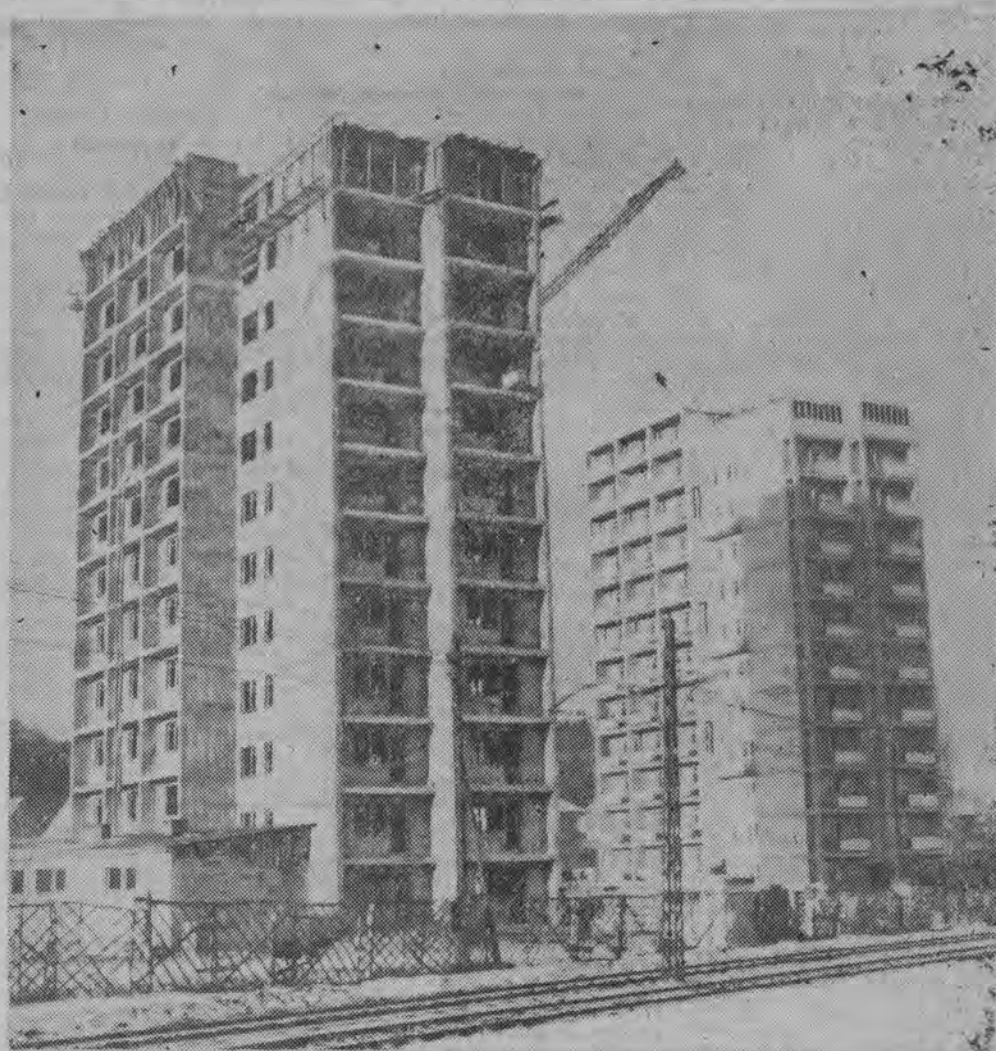
NOWY GDANSK. Kiedy mówimy Gdańsk, kojarzy się to z obrazem starego, wiekowego miasta. Tymczasem obok zabytkowych budowli, ton architekturze miasta zaczynają nadawać efektowne nowoczesne budowle. Oto dwa punktowce w budowie. Jeden z nich należy do Nauczycielskiej Spółdzielni Mieszaniowej.
