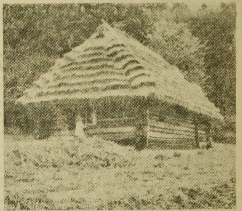
W Sanoku powstaje Muzeum Budownictwa Ludowego. Na teren przyszłego skansenu przeniesione już trzy obiekty: dom mieszkalny ze wsi Dąbrówka k/Sanoka (część tego domu pochodzi z 1881 r.), dom wyrobniaka dworskiego ze wsi Niebecko (pow. Brzozów) oraz cerkiew z 1750 r. znajdującą się dawniej w miejscowości Rosalin (pow. ustrzycki). Wkrótce przeniesione zostaną do Sanoka dalsze obiekty.
