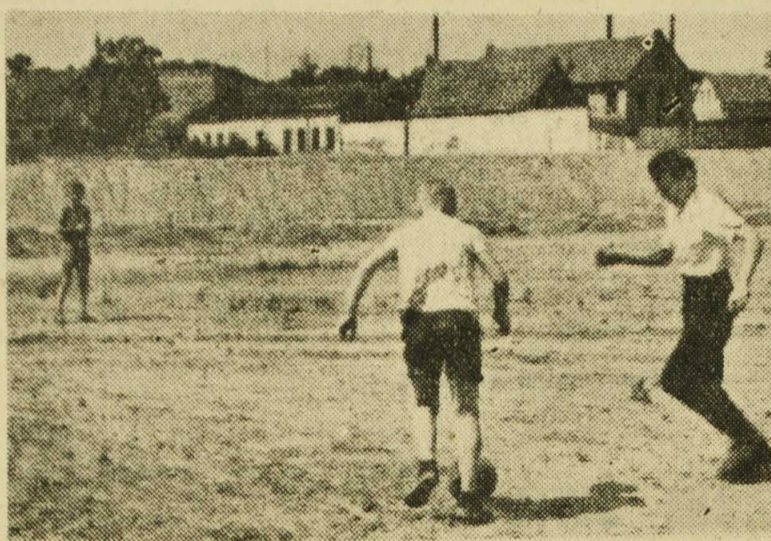
Choć stadion przy ul. Jurowieckiej jest jeszcze w budowie, młodzi entuzjaści piłkarstwa już „trenują” na prowizorycznie zniwelowanym boisku.
