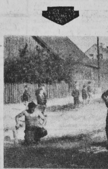
NA ZDJĘCIU: budowa nowej nawierzchni. Fot. P. Sawicki
