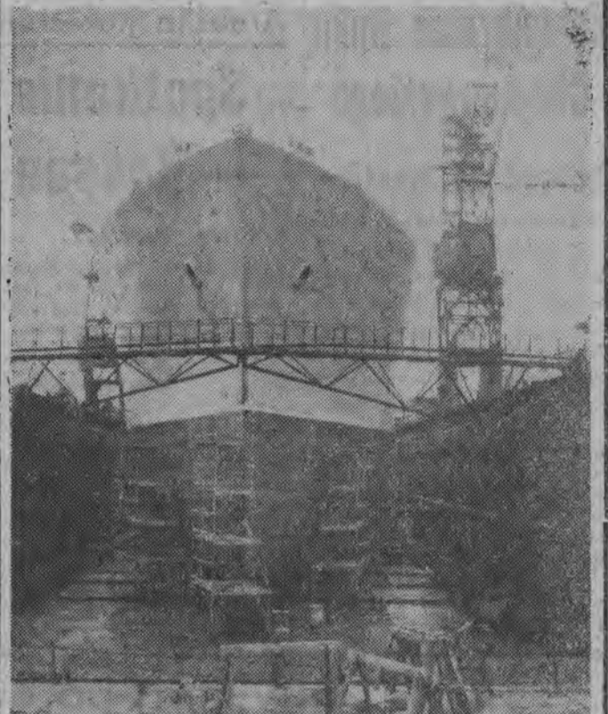
W Szczecińskiej Stoczni Remontowej polna para pracująca nad remontami różnego typu jednostek pływających. NA ZDJĘCIU: dziesięcioletnik Polskich Linii Oceanicznych m/s „Moniuszko” na doku, gdzie poddana jest remontowi podwodna część kadłuba statku. CAF — fot. Wezzer
