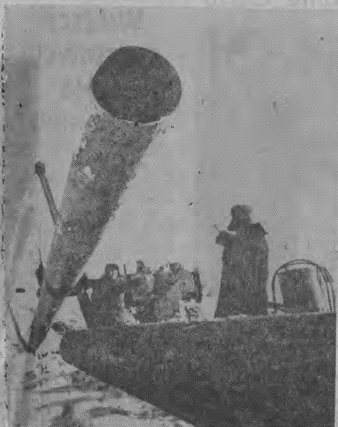
Na budowie gigantycznego ropociągu, którym na dystansie przeszło 2.000 km Związek Radziecki dostarczać będzie ropę naftową do CSRS, Węgier, Polski i NRD — nastąpił nowy etap: poszczególne odcinki rur zostają układane w wykopany uprzednio rów, a następnie spawane.
