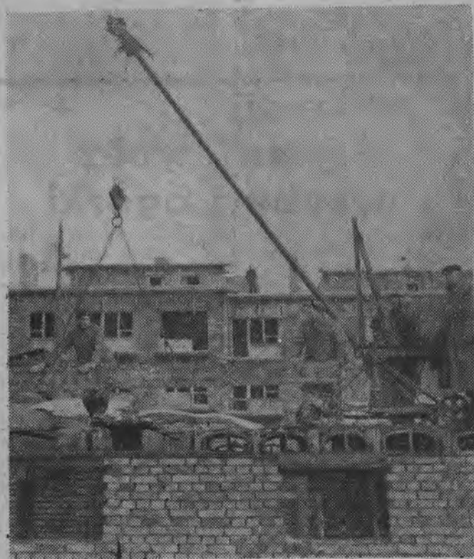
Układanie stropów.
