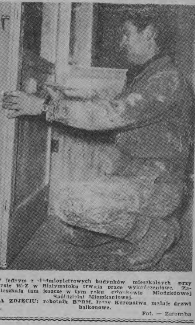
W jednym z 4-10mopletkowych budynków mieszkalnych przy trzele W-Z w Białostoku trwała praca wykończeniowa. Mieszkańcy mieszkać tam jeszcze w tym roku członkowie Młodzieżowej NA ZDJĘCIU: robotnik BPRM, Józef Kuropatwa, maluje drzwi balkonowe. Fot. - Zarembo
