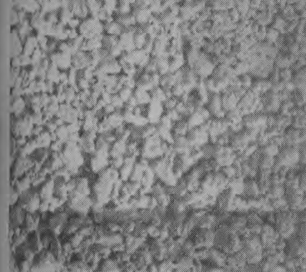
Tak wygląda ściana z betonu jednofrakcyjnego.
