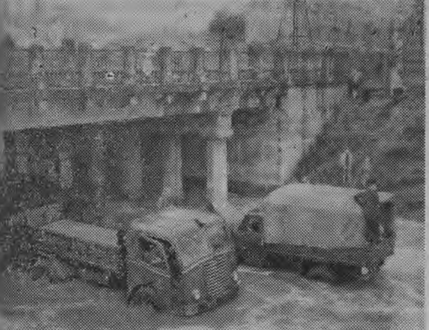
Kilkunastu upałów w całym niemal kraju wywołują liczne burze i ulewne deszcze. ZDJĘCIU: skutki ulewnej deszczu — wiadukt na ulicy Czolgistów w Gdmi.
