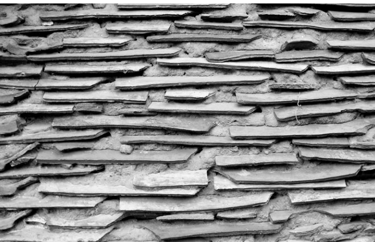
Ryc. 3. Fragment ściany budynku gospodarczego przy jednej z posesji przy ul. Pięknej w Czarnej Wsi Kościelnej, z dachówkowych skorup spajanych gliną. Fot. Inez Horba, 2012
