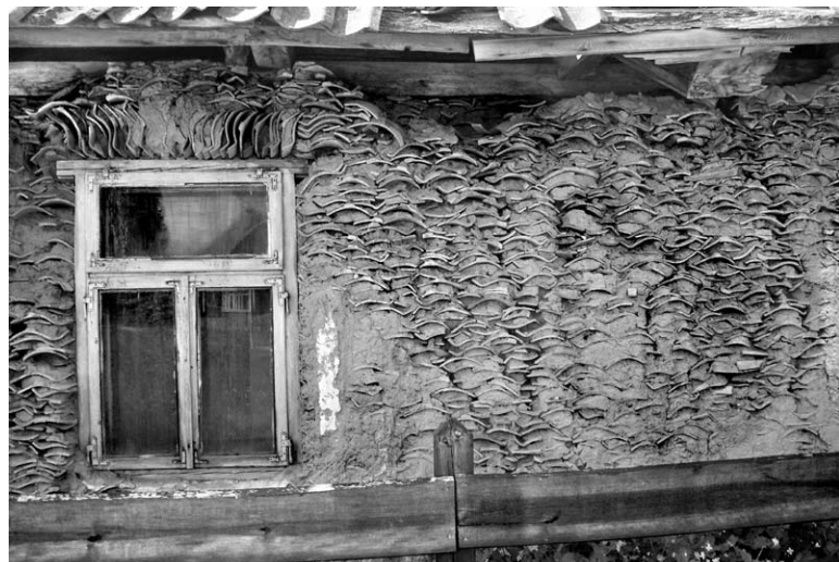
Ryc. 6. Dom nr 34 w Karczmisku – fragment ściany z dachówkowych skorup spajanych gliną. Fot. Inez Horba, 2012
