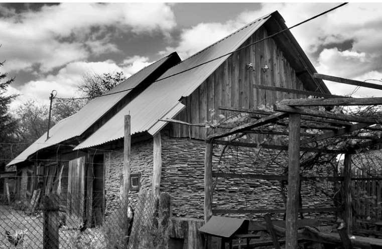
Ryc. 2. Budynek gospodarczy przy jednej z posesji przy ul. Pięknej w Czarnej Wsi Kościelnej, mający ściany z dachówkowych skorup spajanych gliną. Fot. Inez Horba, 2012
