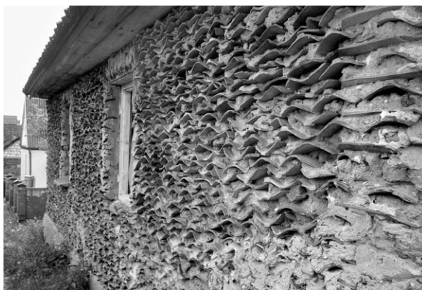
Ryc. 4. Fragment ściany pracowni garncarskiej Stary Młyn w Czarnej Wsi Kościelnej, z dachówkowych skorup spajanych gliną. Fot. Inez Horba, 2012
