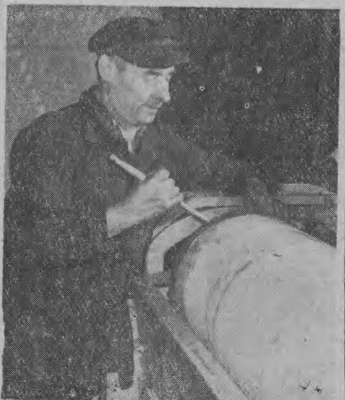
JAN PIENKO przy montażu nowej szklarni, którą zakłady otrzymały w ramach importu z USA.
