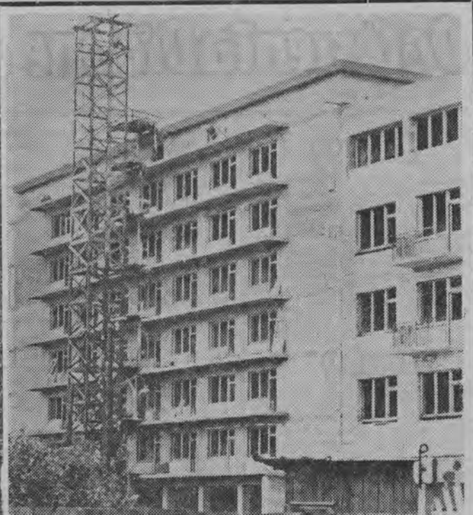
We wnętrzu tego domu trwają prace wykończeniowe. Jest to budynek na rogu Lipowej i Dąbrowskiego. Budynek ten ma zakupić Białostocka Spółdzielnia Mieszaniowa. Fot. — Z. Z.
