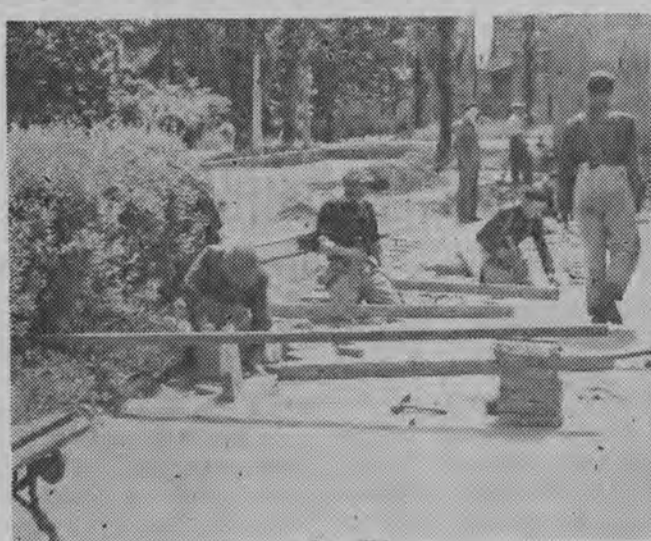
NA ZDJĘCIU: budowa chodnika w parku, przy Teatrze.
