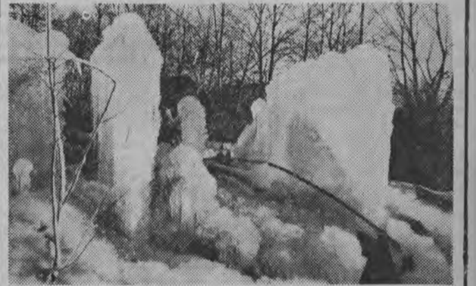
Nagły spadek temperatury wyrządził w mieście wiele szkód. Oto zdjęcie zrobione przy ul. Grotgiera. Pekły tam rury wodociągowe. Na silnym mrozie strumienie wody zamieniły się w lodowe góry. Efektownie to wprawdzie wygląda, ale naprawa wodociągu w czasie zimy nie jest rzeczą ani łatwą, ani taną.
