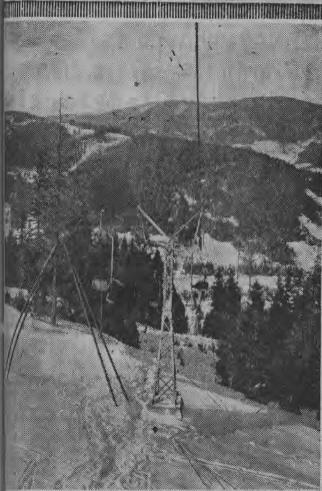
ZDJĘCIU: fragment wyciągu krzeselkowego pod Skrzycznem. CAF — fot. Werner
