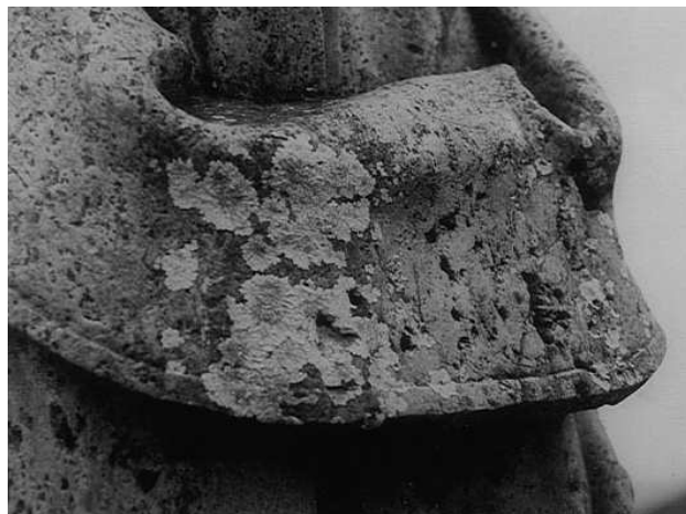
Rys. 3. Wżery spowodowane przez atak porostów na monumencie wykonanym z dolomitu (Becker i in., 1994)
