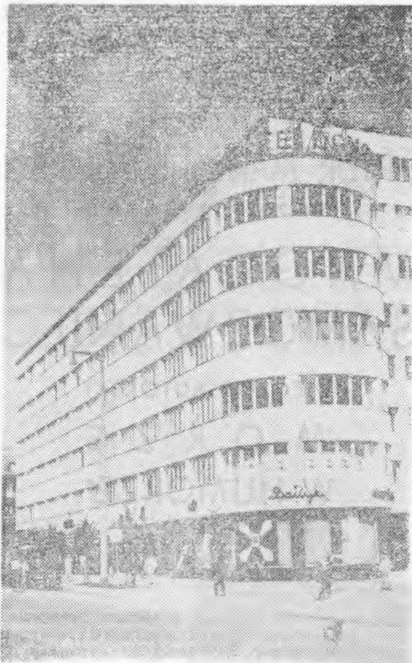
Budynek przy ul. 10 Lutego w którym mieściła się „Cafe Bałtyk” (ze zbiorów Muz. M. Gdyni)
