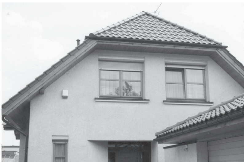
Poniżej - współczesny profil dachu nawiązujący kątem nachylenia połaci, formą naczółka, materiałem pokrycia dachowego, formą dachówki esówki (tradycyjne pokrycie przed II wojną na Podlasiu). Uwagę zwraca detal - drewniane deski szczytowe i okapowe. Przykład realizacji formy i detalu architektonicznego nawiązującego do tradycyjnej architektury Supraśla – profil dachu, skala budynku, we współczesnym domu mieszkalnym z zastosowaniem współczesnych technologii. Fot. autor.
