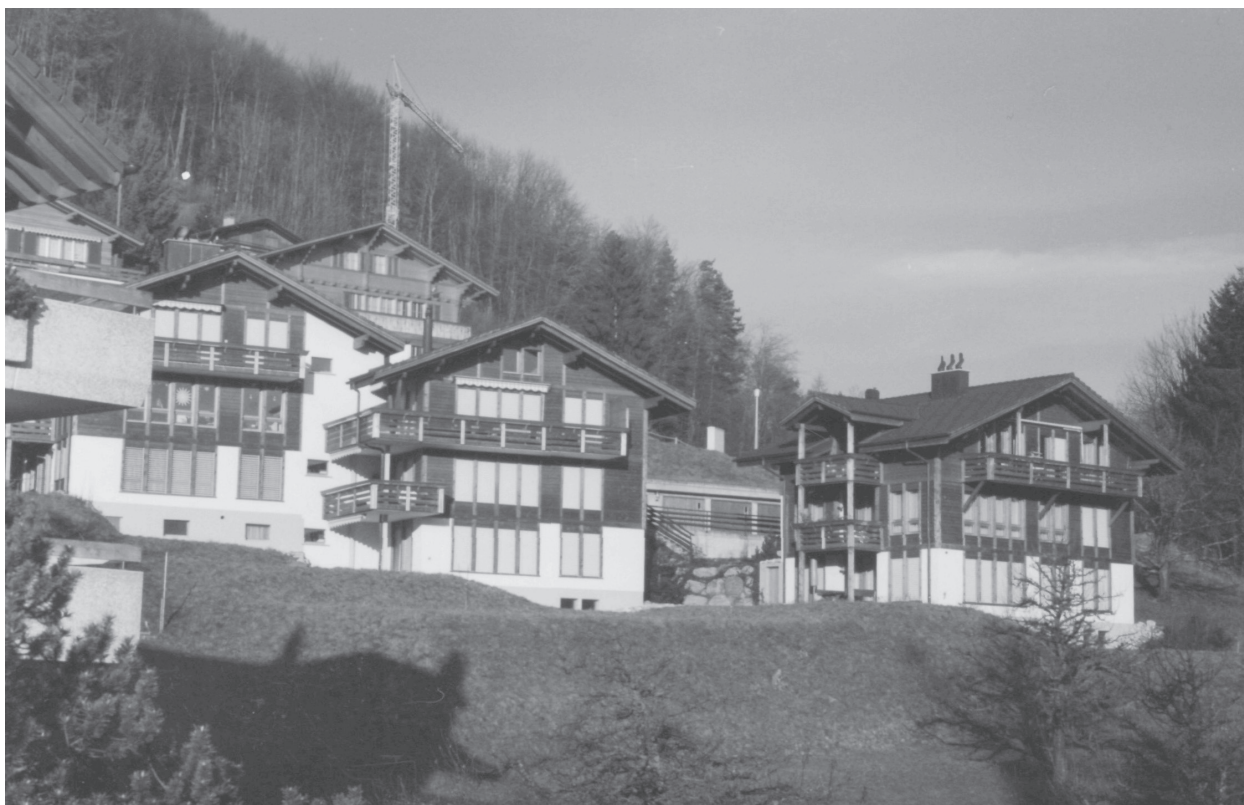
Ryc. 3. Zabudowa mieszkaniowa jednorodzinna miasta Faulensee (kanton Bern - Szwajcaria) o formach współczesnych odpowiednio dostosowanych do charakteru architektury regionalnej. Uwagę zwraca współczesna żelbetowa technologia wznoszenia budynków, współczesny detal deskowania ścian i stolarki okiennej. Zachowane są główne charakterystyczne cechy tradycyjnej architektury regionu Berneroblerland. Elementy formy budynku, takie jak przede wszystkim profil dachu, proporcje elewacji, galerie, balkony, nawiązują do tradycyjnej zabudowy regionu. Fot. autor.
