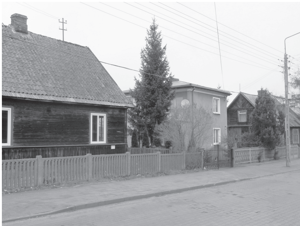
Ryc. 6. Ulica Jagiellońska w Białymstoku. Jeden z licznych przykładów dogęszczenia w okresie PRL tradycyjnej zabudowy mieszkaniowej. W istniejącej strukturze zabudowy wprowadzono budynek o innej formie architektonicznej i usytuowany w głębi, poza tradycyjną linią zabudowy. Fot. autor.
