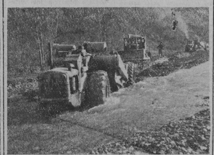
Po przerwie zimowej znowu ruszyły roboty przy budowie nowej drogi Poronin — Bukowina — Godowlia — Morskie Oko. NA ZDJĘCIU: maszyny niwelują teren pod budowę drogi w Kośnych Hamrach przy potoku Poroniec. CAF — fot. Olszewski
