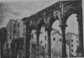
NA ZDJĘCIU: świetnie zachowane kolumny przedsiönka, widocznego do pomieszczeń cesarskich.
