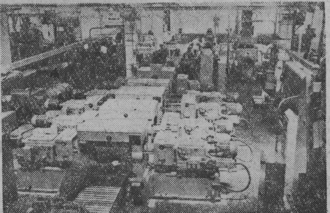
W Czangczun zakończona została w ub. miesiącu budowa pierwszej w Chinach fabryki samochodów.
