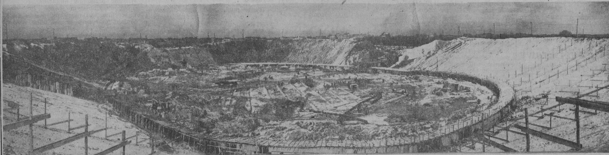
Budowa stadionu festiwalowego w Warszawie w całej pełni. Ogrom i rozmach budowy mówi, jak bardzo młodzież polska jest przejęta rolą gospodarzy Festiwalu. Ileż tu padnie rekordów, a ile będzie radości i emocji w dniach Festiwalu...
