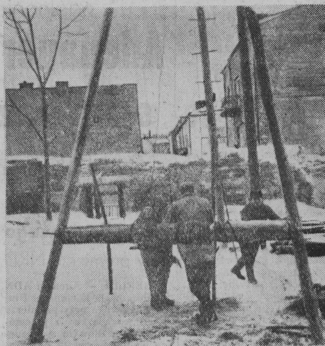
NA ZDJĘCIU: — robotnicy ZBM Maciej Abramowicz, Władysław Przybylko i Jan Chodyko pracują przy wierceniach.
