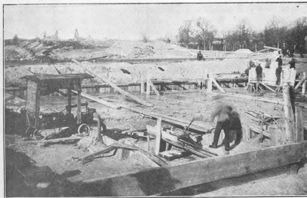
Fot. 2. Piotrków. Kanalizacja. „Oczyszczalnia ścieków” — fundamentowanie zbiornika „Imhoffa” (str. 192).
