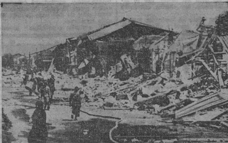
Zdjęcie to dokonane zostało w jednym z najbardziej dotkniętych katastrofą miast, Chillan, gdzie z 40.000 mieszkańców zaledwie 8.000 pozostało przy życiu, a domy zamieniły się w jedno wielkie rumowisko.
