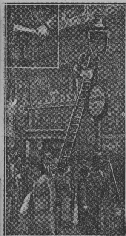
Zaciemnianie lamp ulicznych. U góry w rogu abażur, zakładany na lampy.
