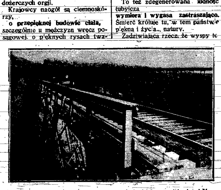
Drewniane mooty wysokości 8 pięt, przerzucone nad przepaściami pod Mo-
