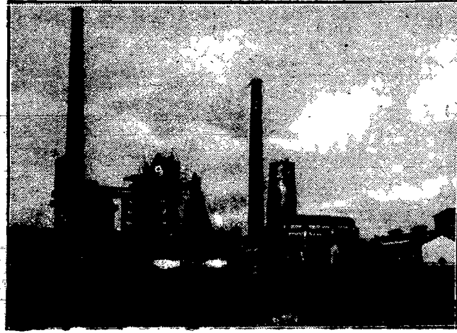
Wielki piec w Starachowicach
