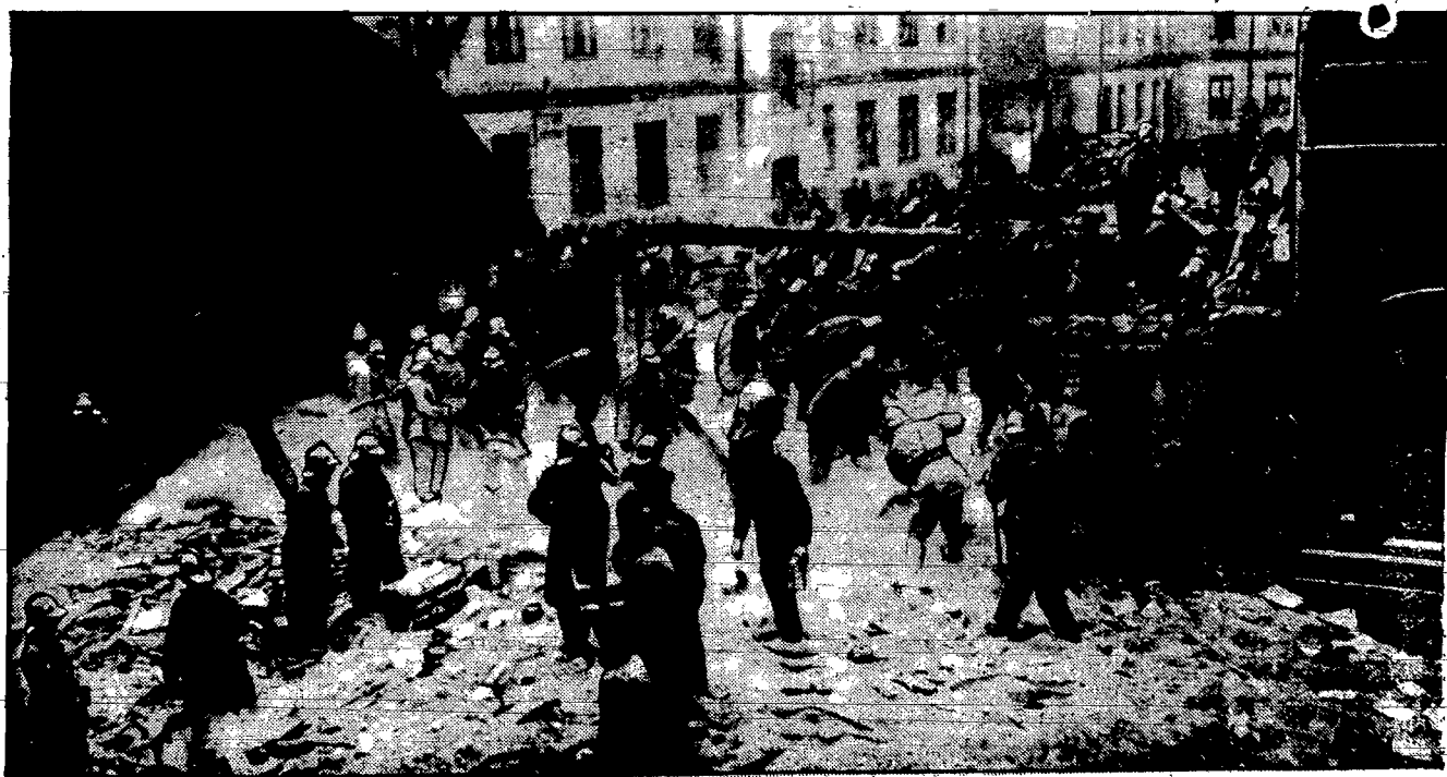
Gorączkowa akcja ratunkowa na miejscu katastrofy przy ul. Krochmalnej, prowadzona przez policję i straż ogólną.
