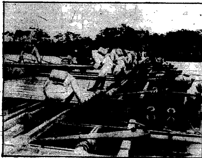
Jesienne manewry pionierów japońskich na przedmieściu Tokio. Saperzy podczas ukła dania mostu pontonowego.
