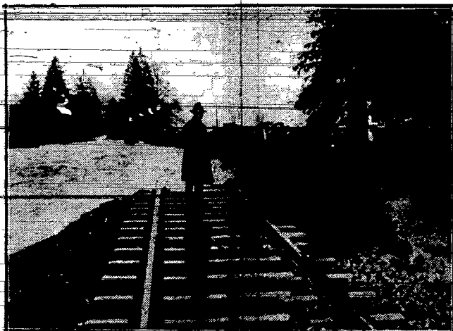
Tor kolejowy pod wodą. (Do art. obok)
