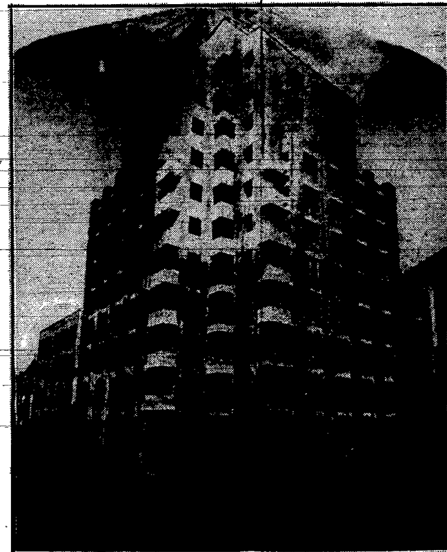
W Katowicach wyciągnięte pod dach 14-to piętrowy drapacz chmur, w którym znajdą pomieszczenie urzędy skarbowe i mieszkania dla urzędników. Jest to najwyższy w Polsce budynek wykonany w konstrukcji stało-szkieletowej.
