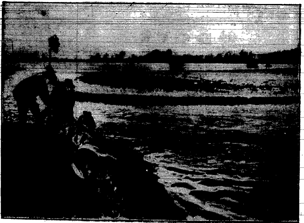
Układa się wału ochronnego z worków piasku i darni na brzegu Odry, której wylew na Śląsku przybrał rozmiary katastrofalne.
