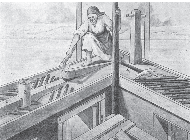
Ryc. 2. Wznoszenie ściany z gliny i chrustu opałowego, warstwowej z kanałami powietrznymi, według Mikołaja Niewierowicza (1930, s.57)
