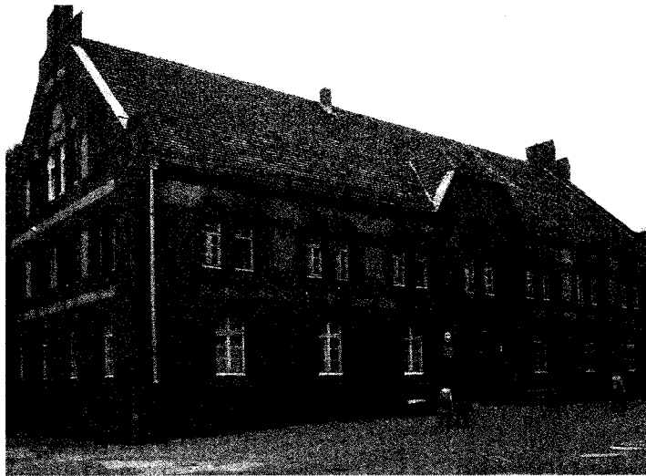
Fot. 3. Budynek dawnej zbrojowni przeznaczony na Bibliotekę Filologiczną Uniwersytetu Szczecińskiego (autor zdjęcia – Mirosława Różycka)
