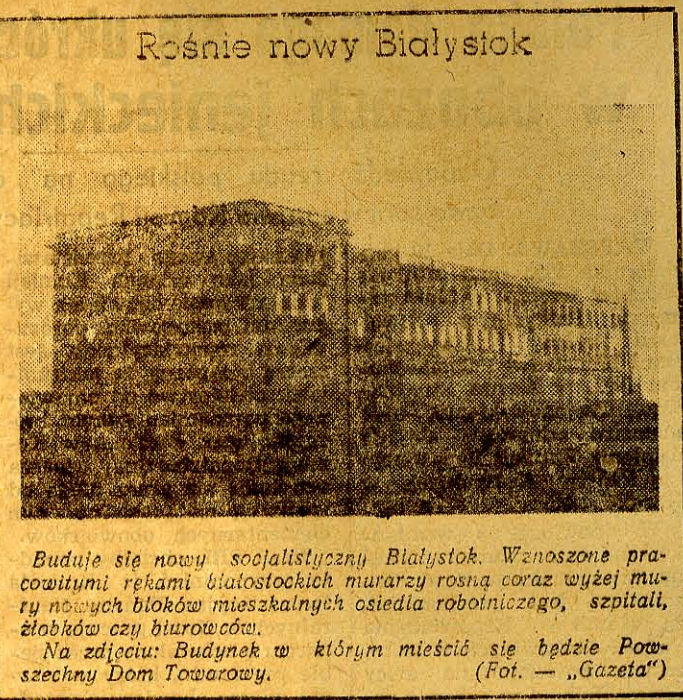
Buduje się nowy socjalistyczny Białystok. Wznoszone pracowniczymi rękami białostockich murarzy rosną coraz wyżej mury nowych bloków mieszkalnych osiedla robotniczego, szpitali, żłobków czy biurówców. Na zdjęciu: Budynek w którym mieścić się będzie Powiatowy Dom Towarowy. (Fot. — „Gazeta”)
