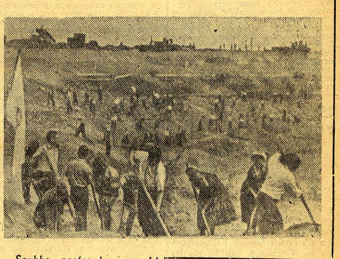
Szybko następują naprzód prace przy budowie Parku Kultury i Sportu im. 23 Sierpnia w Bukareszcie, gdzie odbywać się będą imprezy sportowe i artystyczne.
