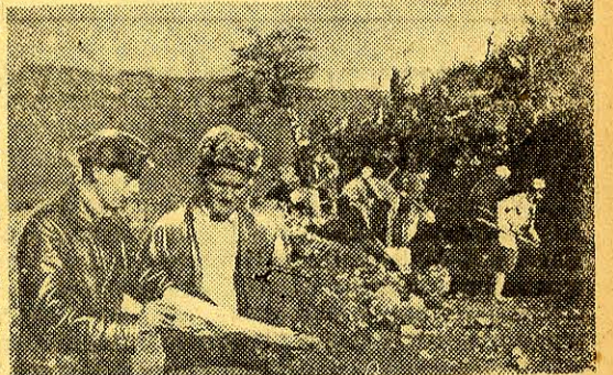
W roku bieżącym rozpoczęto prace przy budowie elektrowni wodnej w Burre w Albanii. Na zdjęciu: Wstępne prace przy budowie elektrowni. Fot. — C A F
