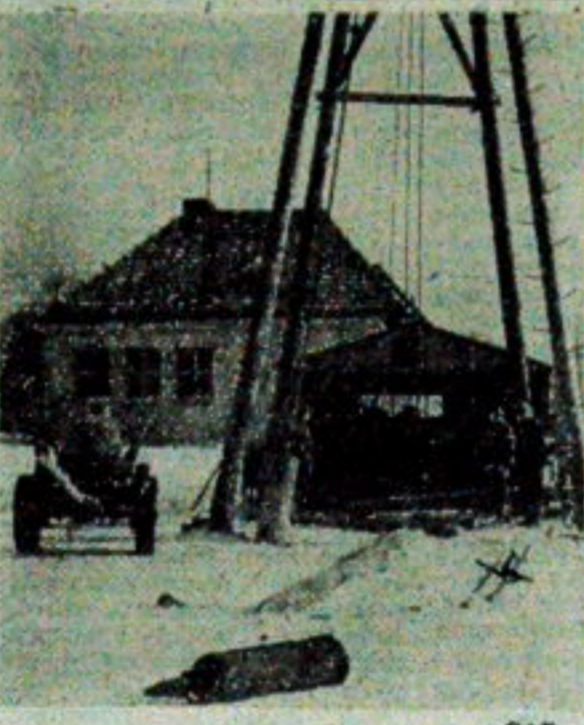
We wsi Mileszki, w woj. łódzkim, Przedsiębiorstwo Zaopatrzenia Rolniczego w Wodzie buduje ujęcie wody dla wodociągu wiejskiego. Studnia o głębokości 39 metrów dostarczy wodę 100 gospodarstwom rolnym, szkole i szpitalowi mleka. Przy budowie zastosowano po raz pierwszy w kraju wynalazek mgr inż. Jerzego Deloffa, polegający na „udarowym“ wydobywaniu urobku w pokładach rwartych przy pomocy tzw. świdera rurkowego. NA ZDJĘCIU: budowa studni głębinowej we wsi Mileszki. CAF — fot. Rozmysłowicz
