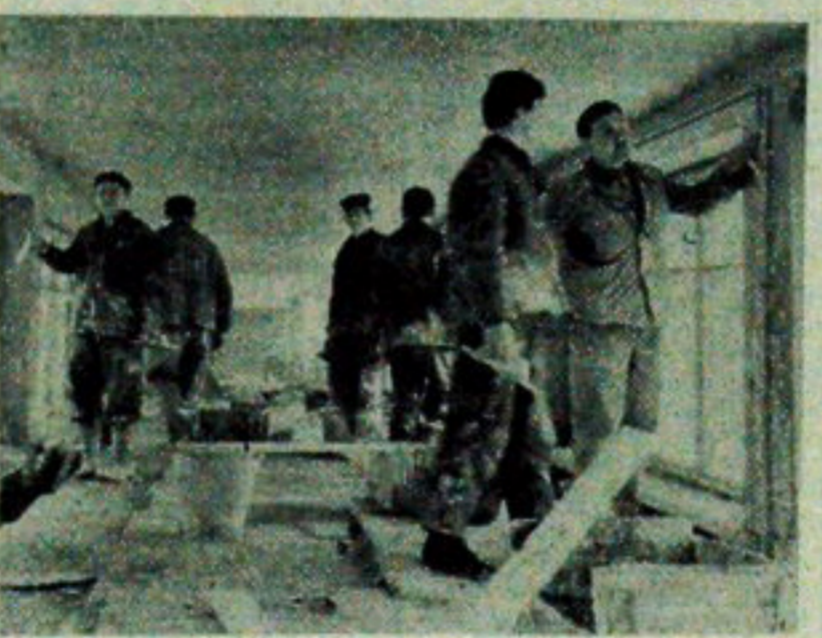
Pod kierunkiem instruktorów uczniowie szkoły budowlanej tynkują pomieszczenia internatu, w którym już za parę miesięcy będą amicy mieszkańcy.
