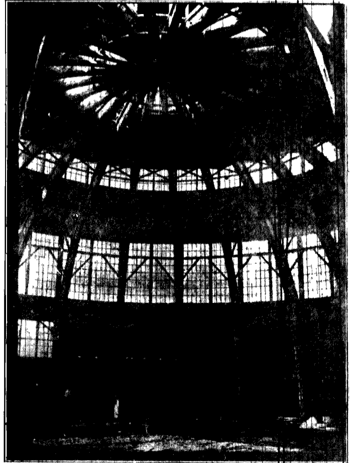
Największa kopła drewniana w E uropie — stanowiła dach dawnie- gu. Konstrukcja: pełne wiązary z desk; rozpiętość walna 30 m., wysokość 18 m.
