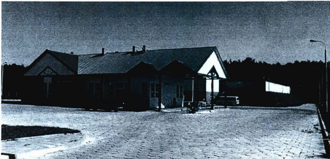
Rysunek 1. Oczyszczalnia ścieków w Sejnach, widok ogólny
