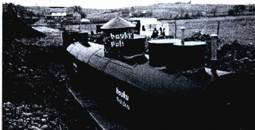
Rysunek 6. Instalowanie reaktora P-M na terenie przetwórnicy mleka
