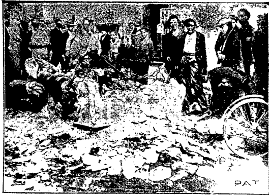
W miejscowości Holden Heath wyleciała w powietrze wielka fabryka materiałów wybuchowych, używanych przez marynarkę angielską. Wybuch był tak silny, że odczuć go w promieniu 30 km. Na ilustracji naszej widzimy gruz jednego z domków przylegających do fabryki, który skutkiem wybuchu uległ zniszczeniu.
