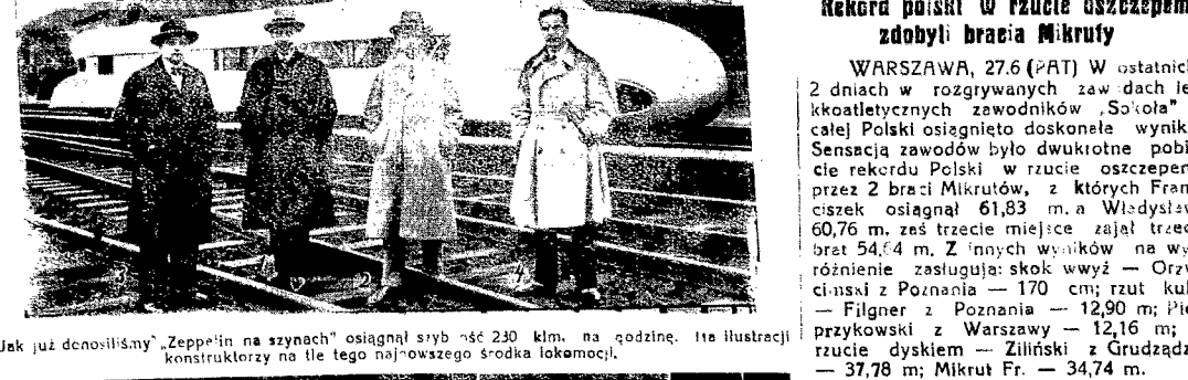
Jak już donosiliśmy, „Zeppelin na szynach” osiągnął srybność 230 km. na godzinę. Na ilustracji konstruktorzy na tle tego najnowszego środka lokomocji.
