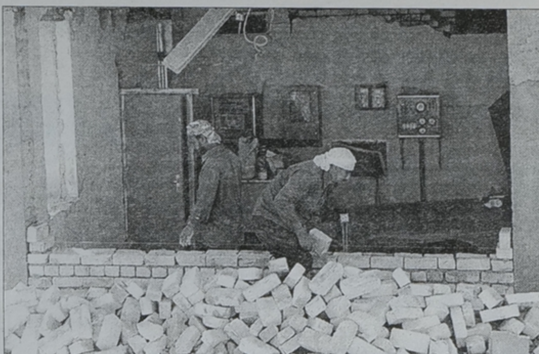
Iraccy robotnicy murują ścianę budynku centralnej poczty w Basrze, zniszczonej podczas ataku rakietowego, w nocy 19 bm.
