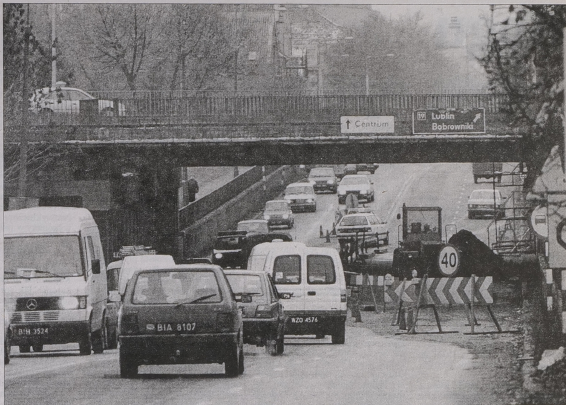
Przejazd ulicą Sienkiewicza pod wiaduktem jest często testem cierpliwości białostockich kierowców. Szczególnie gorąco było tam, kiedy trwał remont.
